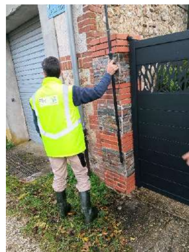
Figure 8 : Nivellement d'une indication de la hauteur maximale atteinte par l'inondation. La pointe de la cane indiquant la hauteur atteinte / Cerema 2024.
